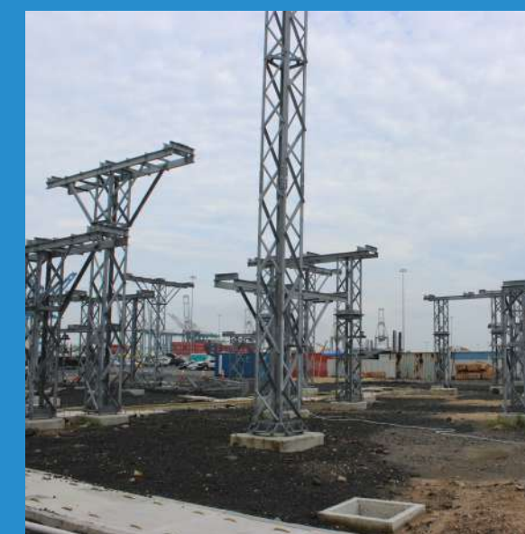
Preparación de infraestructura civil en el lugar donde estará la subestación eléctrica principal de 115,000 voltios.
